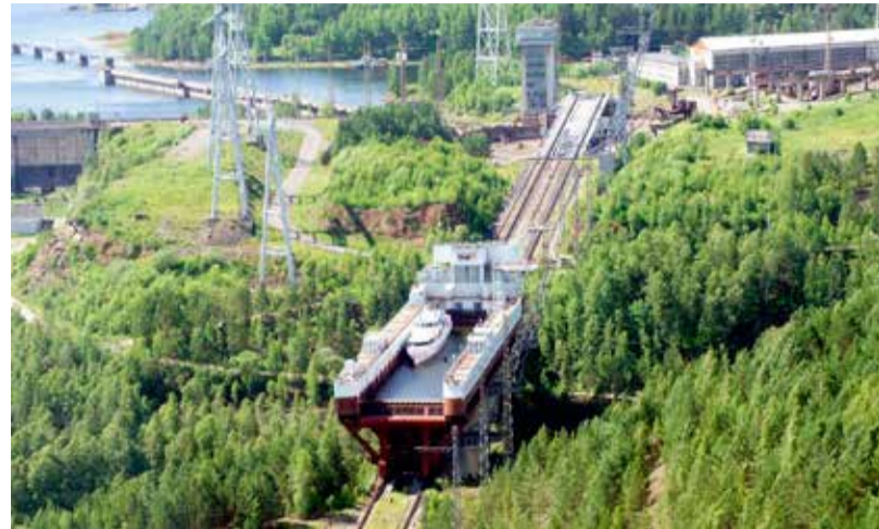
Фото из Telegram-канала «Гидротехника»
