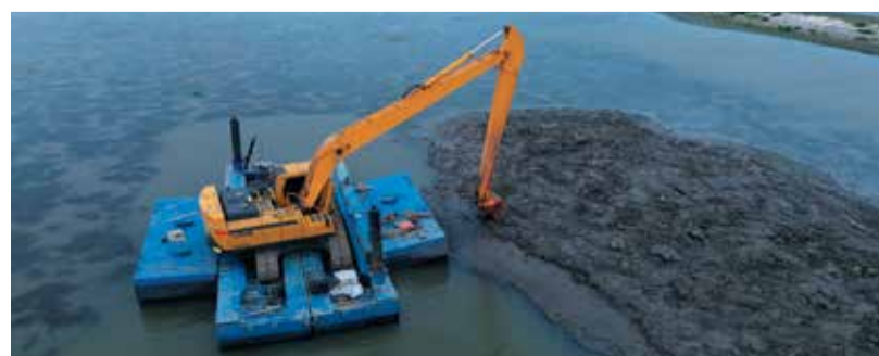
Дноуглубительные работы на ВКМСК. Фото предоставлено ФГУП «Росморпорт»
