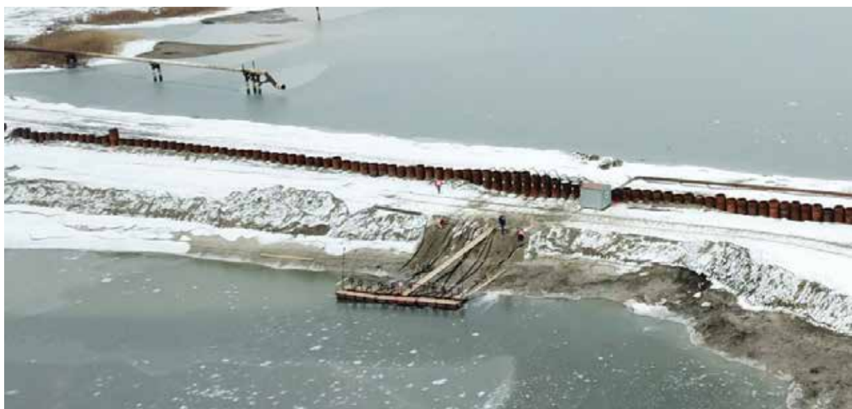
Багаевский гидроузел. Фото с сайта АО «Стройтрансгаз»
