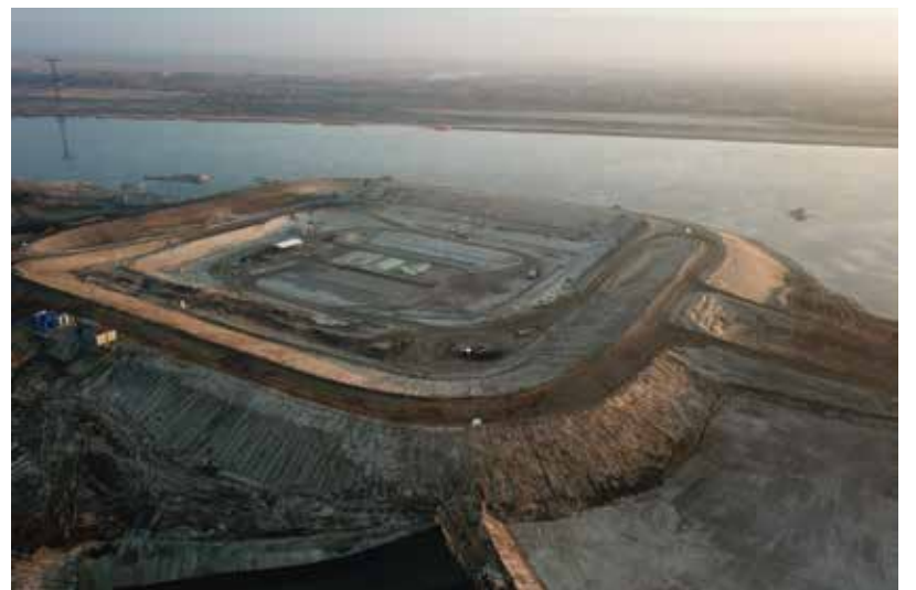
Багаевский гидроузел. Фото предоставлено АО «Стройтрансгаз»
