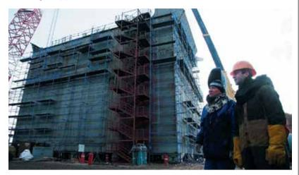
ак сообщается в блоге губернатора Жилкина, большая часть строительных работ уже выполнена — два опорных блока общим весом 5400 тонн и высотой 17,5 метра готовы на 90%. «Остались работы по очистке, окраске и по системам трубопроводов», — уточнил главный инженер предприятия Валерий Шайдулин. — Всего в реализации проекта задействовано около тысячи рабочих».
