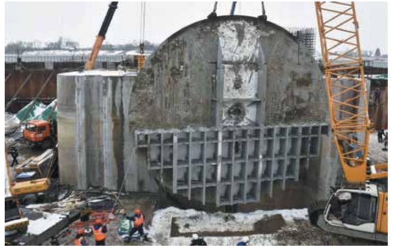
Строители завершили установку дисков поворотного затвора на четвертой секции гидроузла
